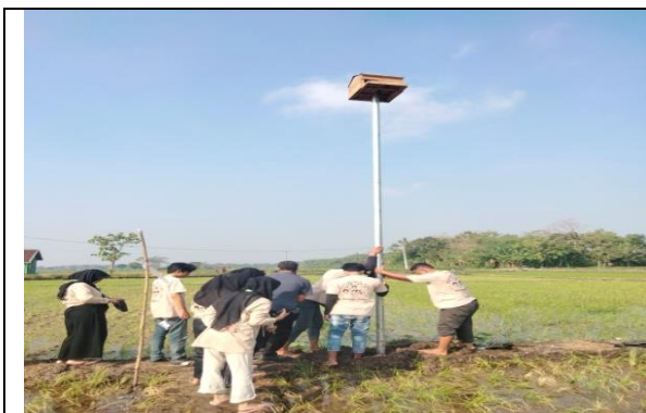
Gambar 3. Pemasangan Rumah Burung Hantu
